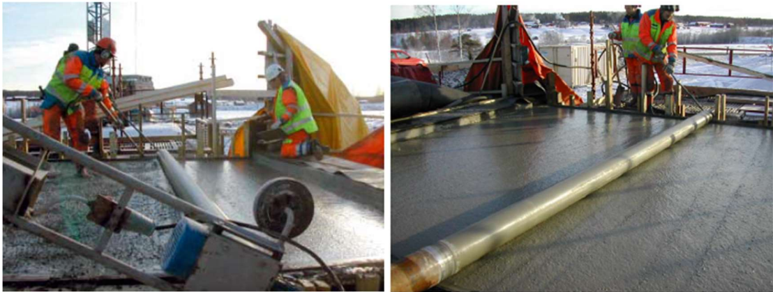
Figur 1.4 Gjutning av självkompakterande slitbetong med en försiktig ytvibrering i två omgångar, Jannok (2004).
